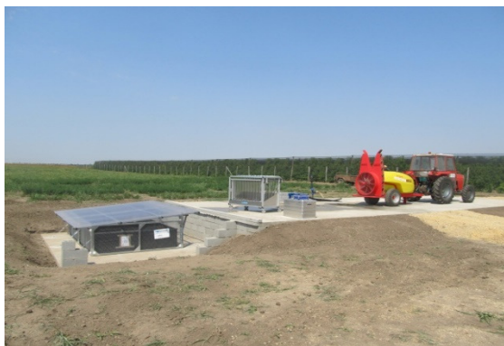
Plato za ispiranje prskalice i Heliosec u kom se sakuplja otpadna voda
