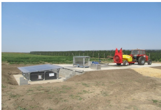
Plato za ispiranje prskalice i Heliosec u kom se sakuplja otpadna voda
