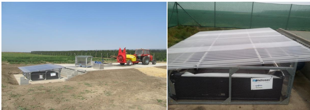
Plato za ispiranje prskalice i Heliosec u kom se sakuplja otpadna voda
